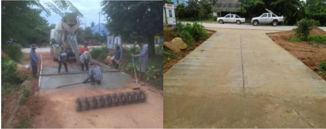
ก่อสร้างถนน คสล. บ้านป่าไร่ หมู่ที่ 9
