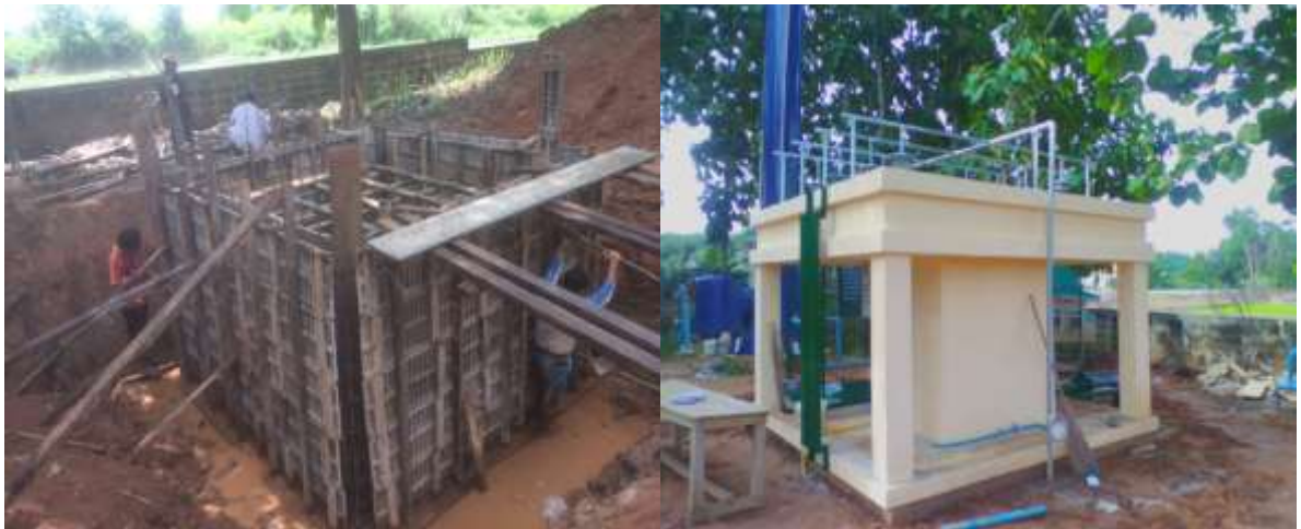
ก่อสร้างระบบประปา (กรองน้ำ) บ้านท่าข้าวเปลือก หมู่ที่ 7
