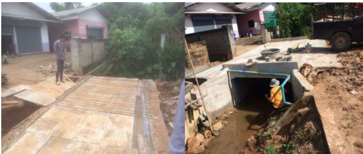
ก่อสร้างท่อลอดเหลี่ยม คสล. บ้านศรียางชุม หมู่ที่ 13
