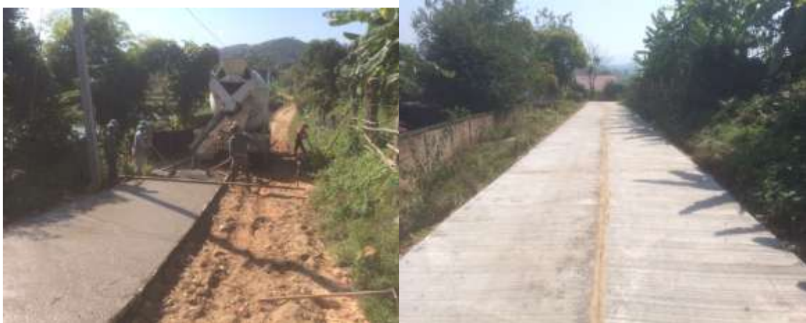
ก่อสร้างถนน คสล. บ้านผ่านศึก หมู่ที่ 10
